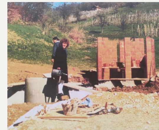
Gradnja črpališča Ždinja vas, 30. 3. 1994
