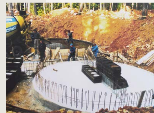
Betoniranje talne plošče za vodohran Ušivec, 25. 4. 1994
