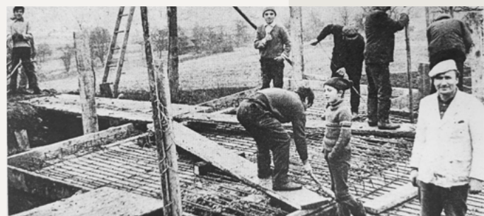
60 kubičnih metrov bo držal vodni zbiralnik, ki ga gradijo v Gornjih Kamencah. V nedeljo, decembra, so po volitvah zbiralnik betonirali (na sliki). Prostovoljnega dela se je udeležilo 25 lju med njimi tudi muzikant Henček Burkat, ki je pomagal pri dovozu materiala s traktorjem. (Foto Zoran)
