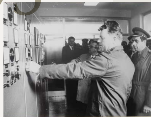
Monter Vinko Klobučar je s pritiskom na stikalo prvič vklopil črpalke v črpalnišču Jezero, 29. 10. 1975
