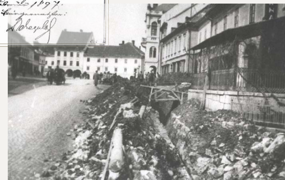
Gradnja vodovoda skozi Glavni trg, leto 1902
