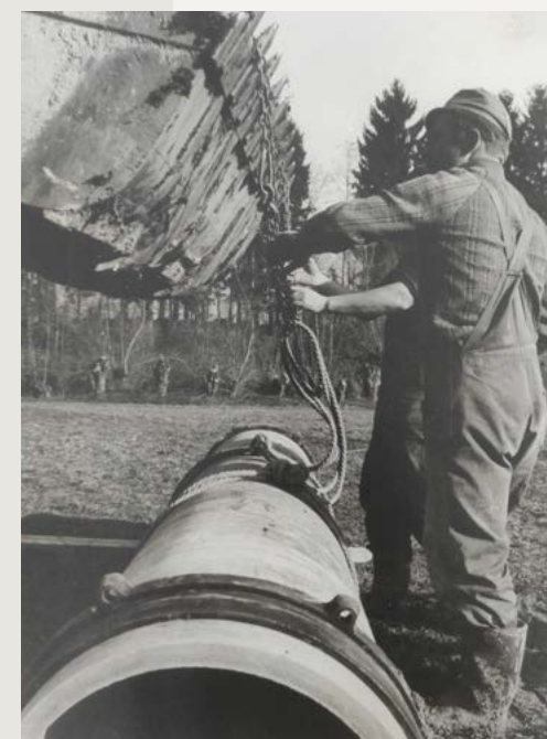
Popravilo magistralnega vodovoda DN 500 na Lešnici, leto 1987
