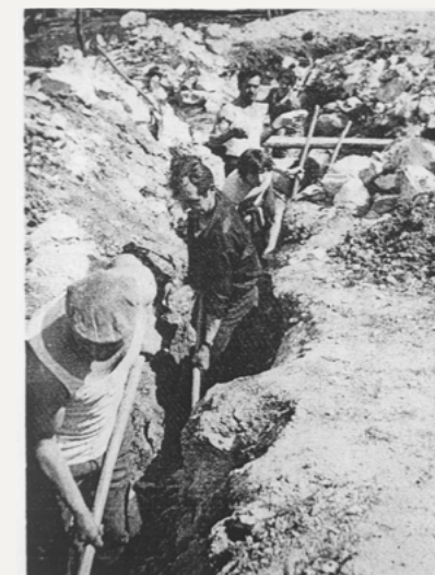
OREHEK V AKCIJI – Prejšnjo nedeljo vaščani Orehka pri Stopičah niso počivali: že zarana so se odpravili, da bi dokončali izkop približno tri kilometre dolgega jarka za vodovod Stopiče–Dolž–Mali Orehek. Na posnetku je ena izmed delovnih skupin. (Foto: Feliks Orel)
