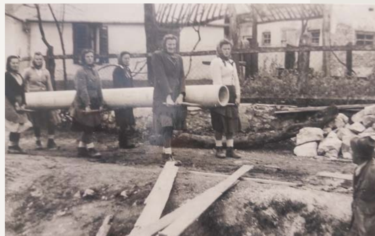
Pri izgradnji vodovoda so imele pomembno vlogo tudi ženske, ki so med drugim zasipavale in tudi nosile cevi (na fotografiji nosijo težko azbest-cementno cev DN 250), leto 1954
