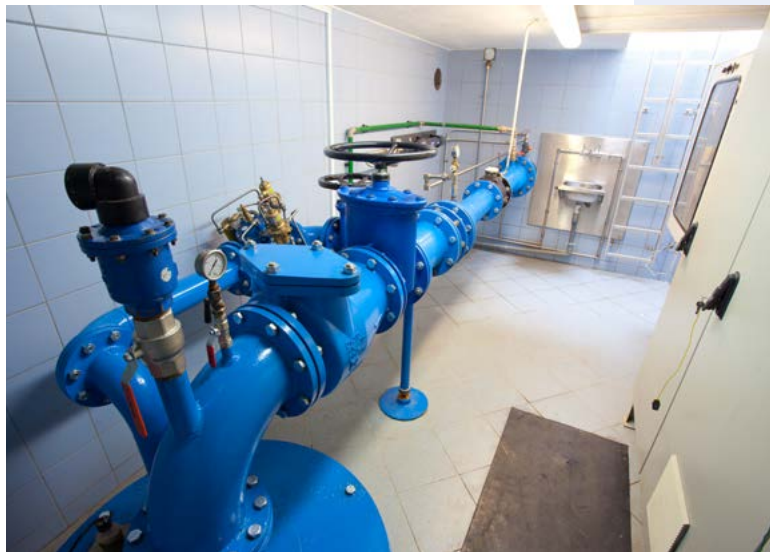
Notranjost vodnjaškega objekta
