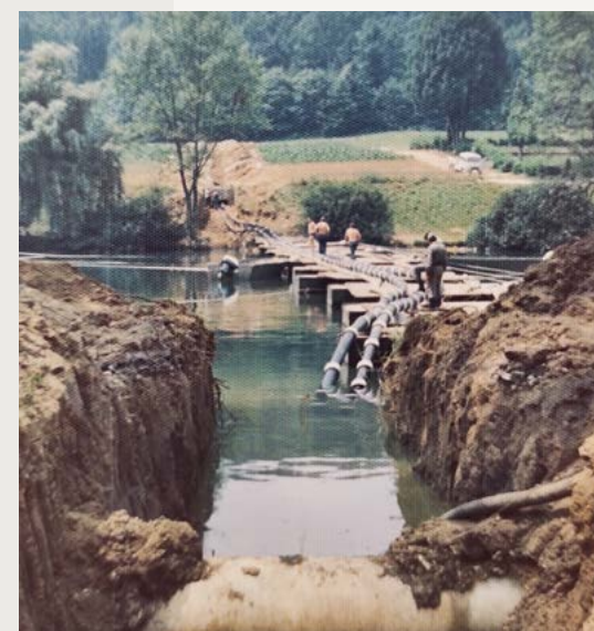
Gradnja vodovoda čez reko Krko na Loki, leto 1976
