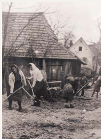
Pri izgradnji vodovoda so imele pomembno vlogo tudi ženske, ki so med drugim zasipavale in tudi nosile cevi (na fotografiji nosijo težko azbest-cementno cev DN 250), leto 1954
