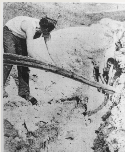
30. septembra so delavci novomeškega Vodovoda polagali vodovodne cevi do novega stanovanjskega naselja nad Stopičami; odkop in zasip jarkov so opravili prebivalci, prispevali pa bodo še po 3.000 dinarjev na gospodinjstvo. Stroške za kompresorska dela in miniranje je poravnala KS Stopiče. (Foto: Feliks Orel)
